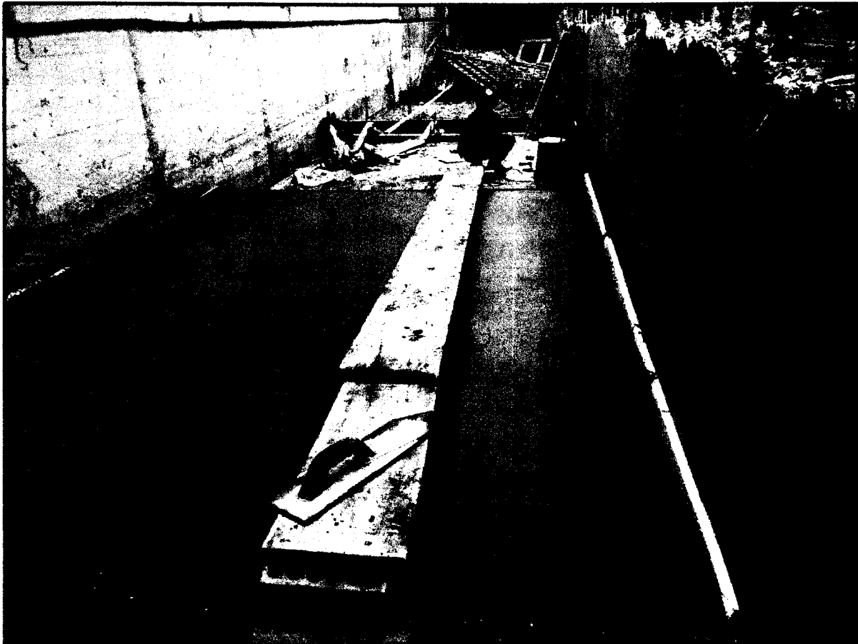
Fig. 5 VACIADO DE CONCRETO F'C=280 KG/CM2 Y TARRAJEPO CON IMPERMEABILIZANTE
